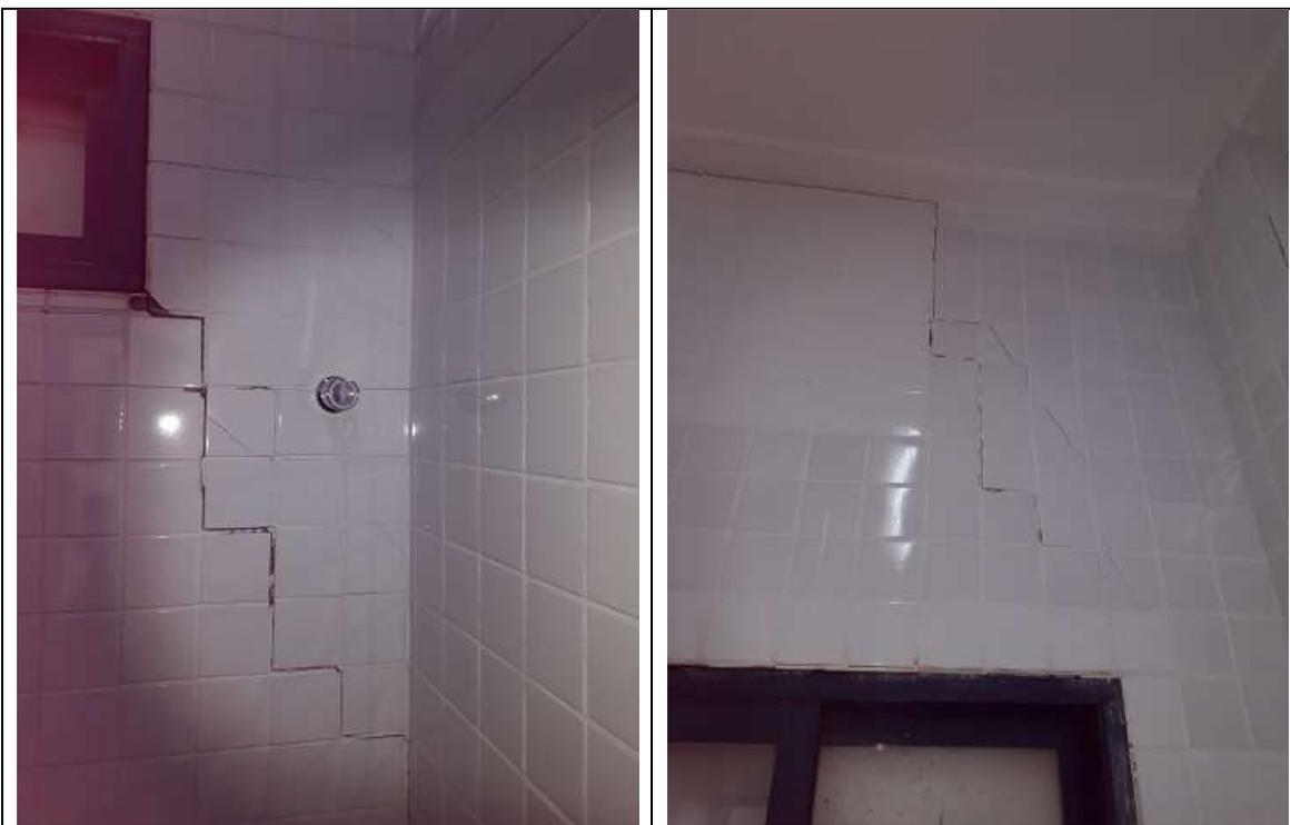
Foto – Rachaduras na parede do banheiro feminino. Parede bastante quente, Serra Talhada (PE), 25/9/2018
