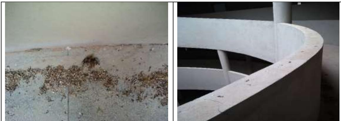
Foto - Acúmulo de sujeira (inclusive resto de animais e seus excrementos) na rampa interna de acesso aos pavimentos do bloco, o que podia ser encontrado em todo o prédio e denota longo tempo de abandono da obra inacabada, Serra Talhada (PE), 25/9/2018
