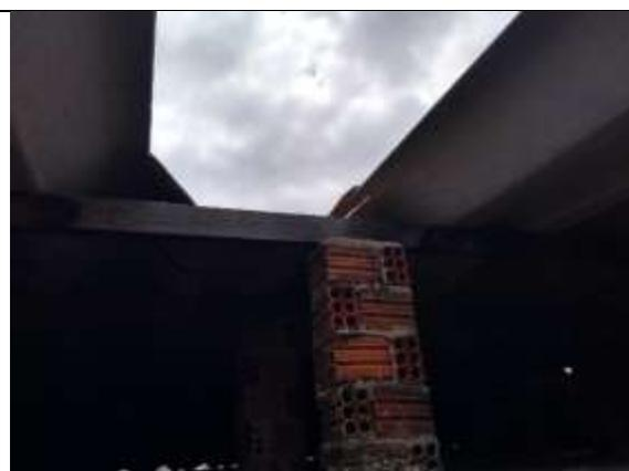
Foto - Ausência de telha ou telha quebrada na cobertura, Serra Talhada (PE), 25/9/2018
