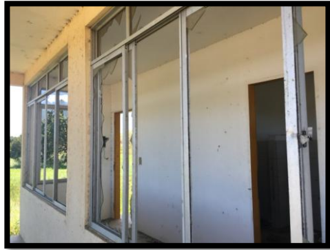
Foto 06 – Janelas com vidros quebrados
