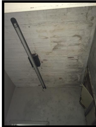
Foto 02 – Teto do banheiro
